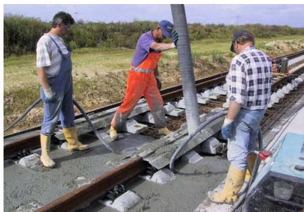
Slika 10. Ugradnja betona u kolosijek kod sustava „Rheda“ [10]
